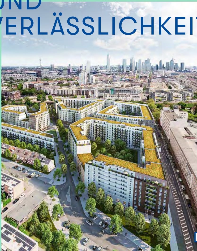
1 Blick auf das zukünftige Quartier „Westville“, das derzeit im Frankfurter Gallus-Viertel entsteht
